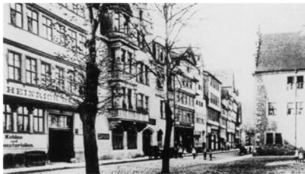
Ziegelstraße – Archiv: Photo Burkhardt
